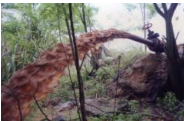
160kW矿用立泵 出水口喷沙照片
